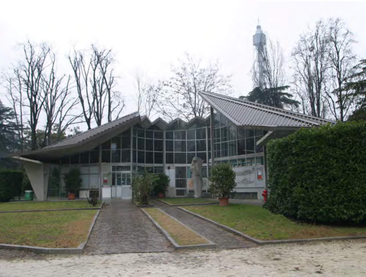
Vista esterna della biblioteca
