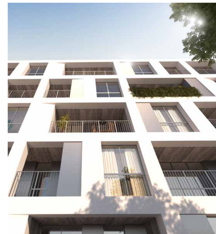
Facciata con logge
