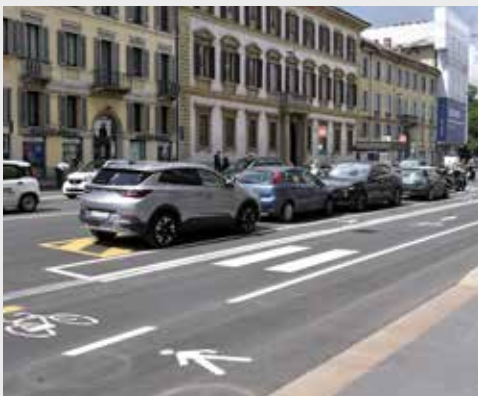
↑ Strada riqualificata e declassata in ottica ciclo-pedonale
